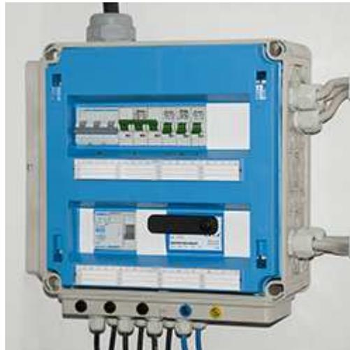
Il sistema di allarme SMS installato in una centralina chiusa
