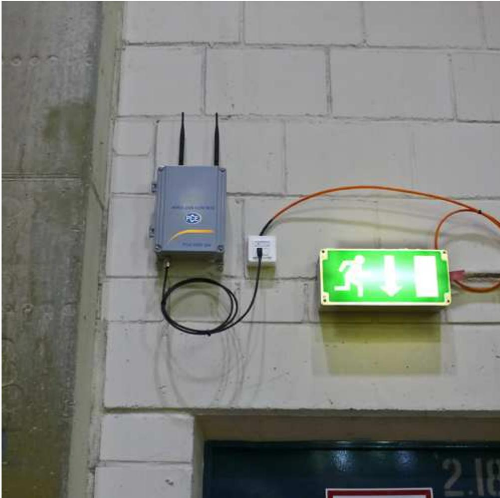
**Sensore delle vibrazioni del sistema wireless di rilevazione delle vibrazioni
