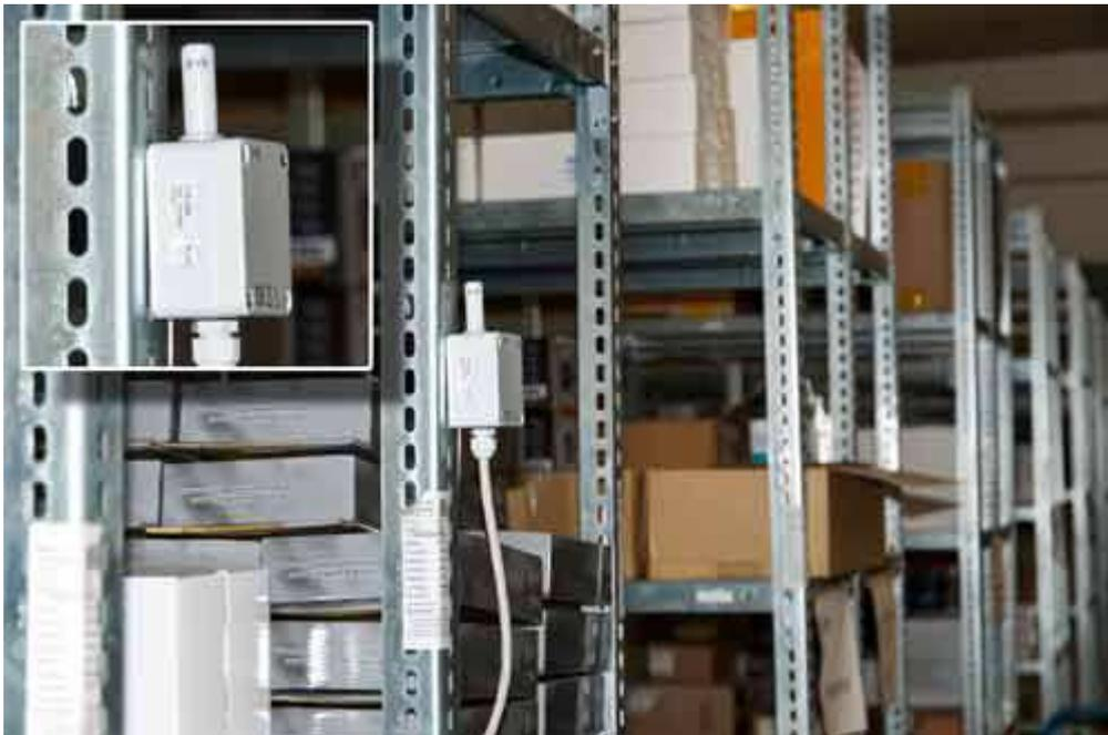
Il sensore del sistema di vigilanza per magazzini può essere montato direttamente in qualsiasi punto del magazzino. Il collegamento viene effettuato attraverso la connessione RJ45 e tramite questa via collegare il sensore attraverso qualsiasi cavo di rete all'unità principale.
