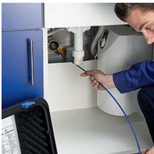
Con il videoendoscopio potrà individuare guasti, per esempio in una rete fognaria di un edificio.
