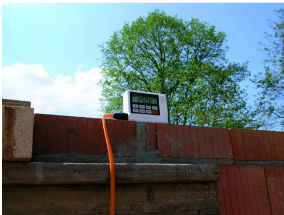
L'altimetro di precisione durante la misura di un muro in lavori di costruzione.
