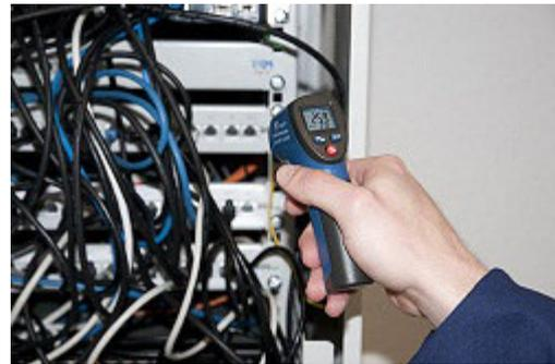
Misurando la temperatura con il termometro senza contatto in un armadio di distribuzione
