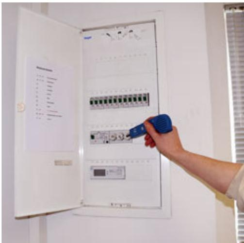
Test per verificare quali cavi appartengono al circuito elettrico con il PCE-180 CBN
