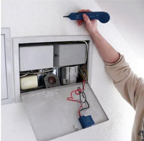
Rilevamento acustico dei cavi con il rilevatore di cavi PCE-180 CBN
