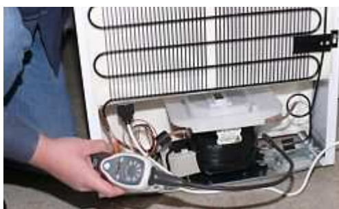
Rilevatore di fughe mentre viene usato in un sistema di refrigerazione
