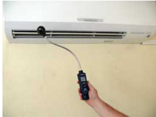
Il termoanemometro con ruota ad alette mentre controlla un condizionatore d'aria
