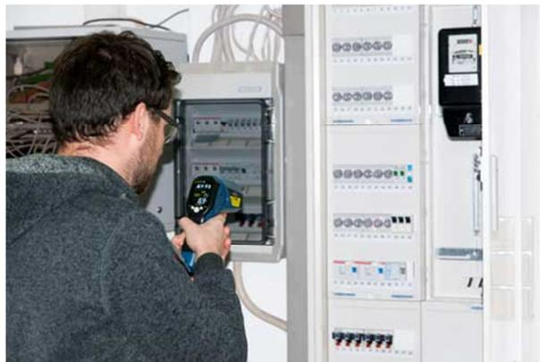
Uso del PCE-895 per il controllo della temperatura in un quadro elettrico
